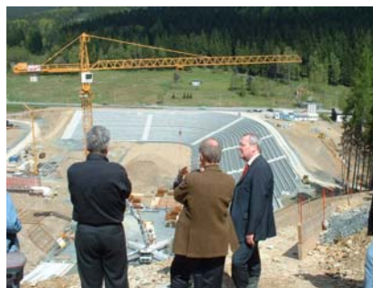
An der Baustelle der Vogtlandarena
