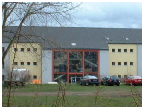
Die sanierte Plauener Karl-Marx-Schule
