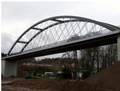
Die neue Eisenbahnbrücke auf der Sachsen-Franken-Magistrale bei Straßberg
