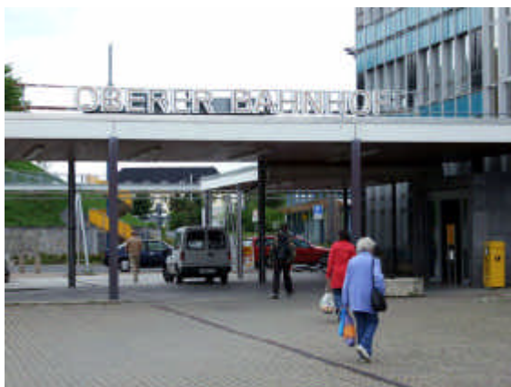
Oberer Bahnhof in Plauen: Das Empfangsgebäude wird mit Mitteln des Konjunkturprogramms saniert
